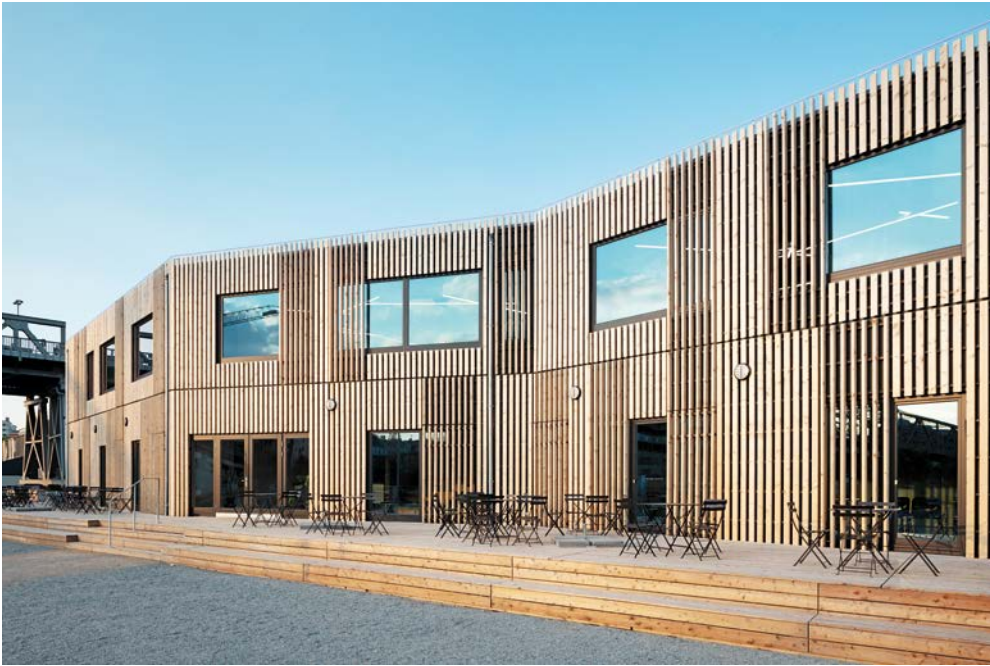
Das „B-Part Am Gleisdreieck“: Mitten in Berlin vermischen sich Coworking, Kultur und Sport und ein Urban Ideation Lab in einem ungewöhnlichen Gebäude in Vollholzbauweise. Das Haus kann zu einem späteren Zeitpunkt abgebaut und an einem neuen Ort wieder aufgebaut werden.
